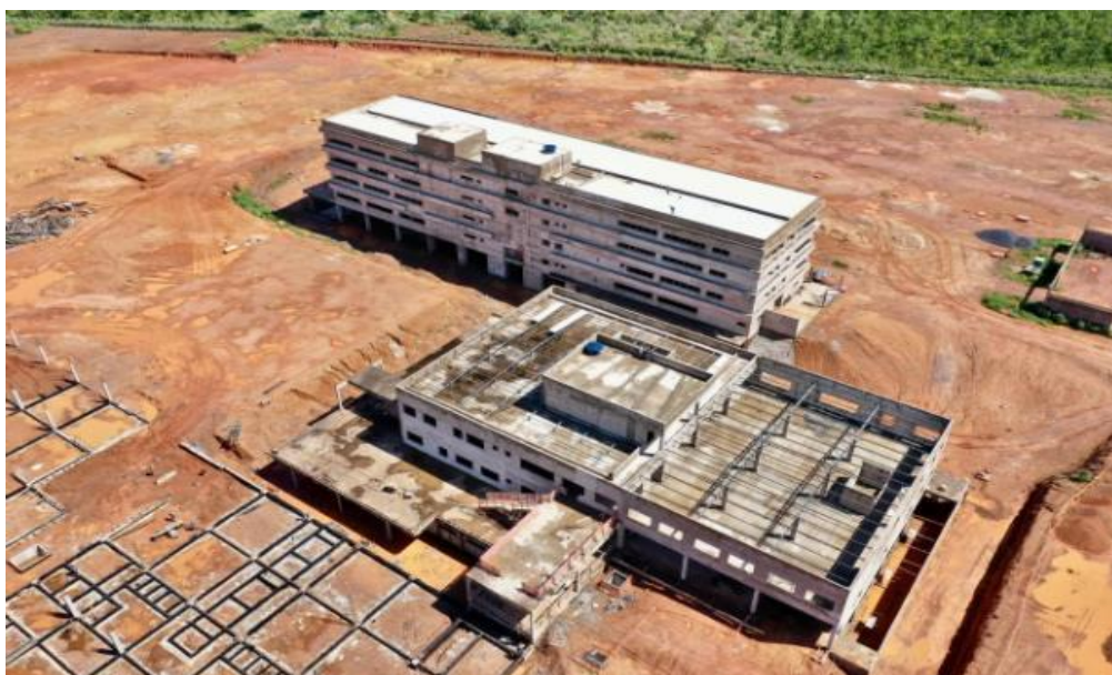
Figura 9 . Vista aérea das obras de Construção do novo Hospital Universitário Júlio Müller
