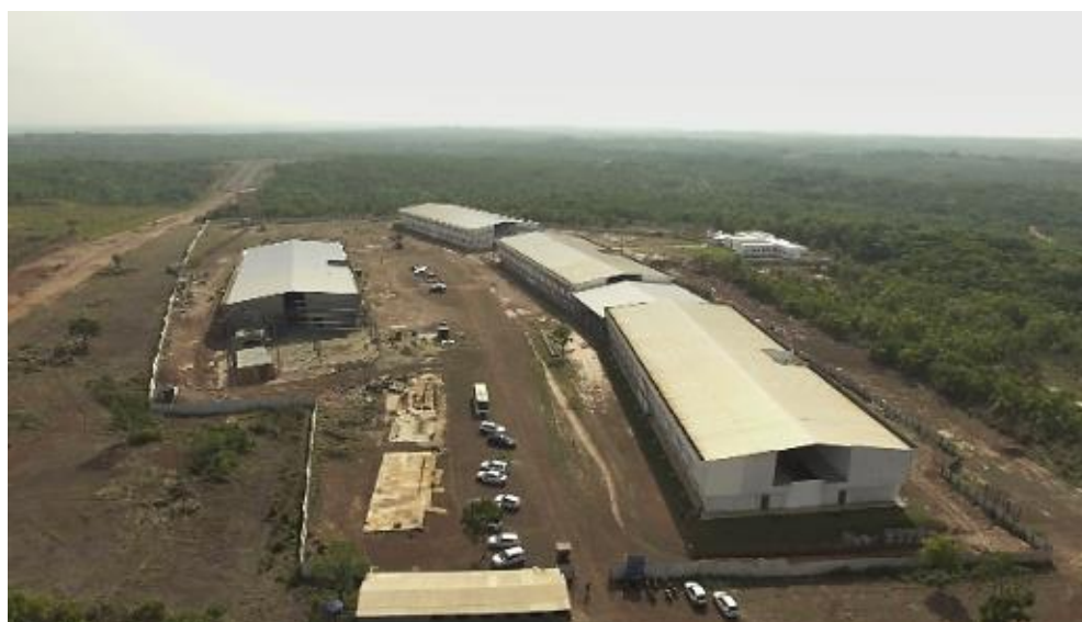
Figura 8 . Vista aérea das obras de Construção do Campus Universitário de Várzea Grande
